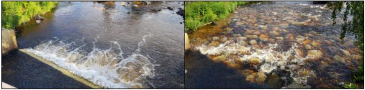
Kuva 12. Patokynnyksen kunnostustoimenpide Alånissa ennen toimenpidettä vasemmalla ja toimenpiteen jälkeen oikealla (Kuva: Loppuraportti Perämereen laskevia vesistöjä, Menetelmien kehittäminen ja ekologinen kunnostaminen, yhteenveto).
